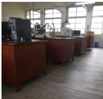
化工科：分析實驗室改善天花板漏水、油漆剝落、翻新木地板、排水系統等
