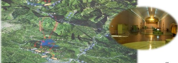
目前計有：大觀二廠、明潭等共10部機組，合計 2602MW。
